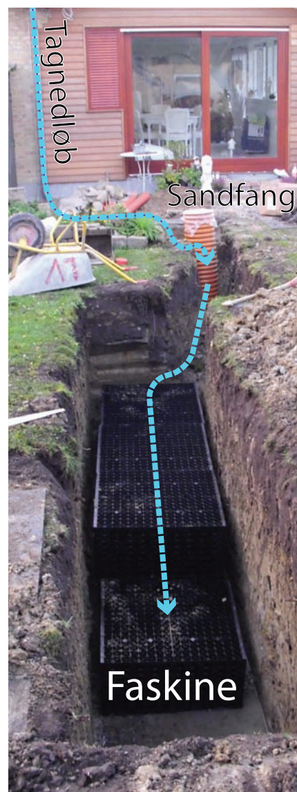
Figur 4: Faskine under udførelse. Tagvandet ledes via en sandfangsbrønd (lodret orange rør) til faskinen i billedets forgrund. Denne faskine er opbygget af plastkassetter. Lindevang, Brøndby. Foto Spildevandscenter Avedøre.
