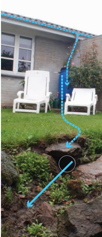
Figur 5: Tagvandet ledes via et rør til regnbedet (i forgrunden skjult under en sten). På nedløbsrøret er opsat en tønde til opsamling af regnvand til havevanding. Slagslunde, Egedal Kommune. Foto Orbicon.
